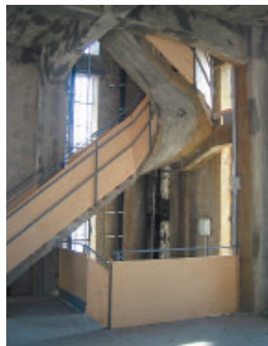
Scala interna di collegamento ai vari piani.
