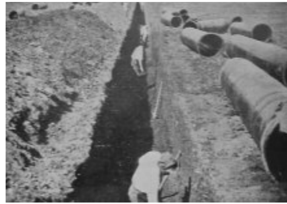
Realizzazione rete idrica.
